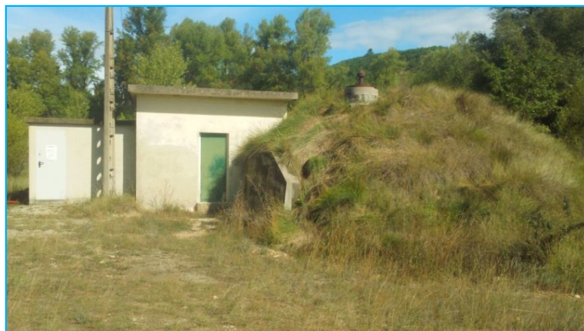
Photo 3 : bache tampon de refoulement (sous son dôme végétalisé), local de pompage et stockage de chlore
